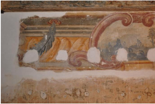
Particolare durante la stuccatura
